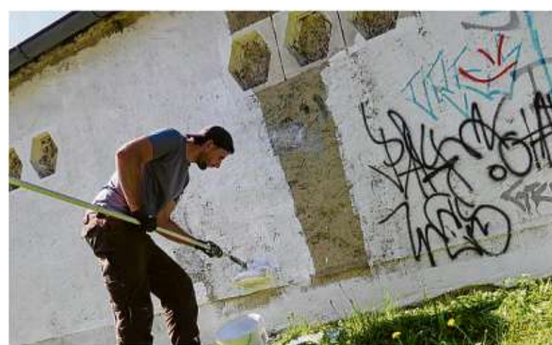
Kollegen des Bauhofes der Stadt Calau haben mit weißer Wandfarbe die Rückseite des Garagenkomplexes in der Karl-Marx-Straße für das Projekt hergerichtet. Foto: Stadt Calau/Jan Hornhauer
